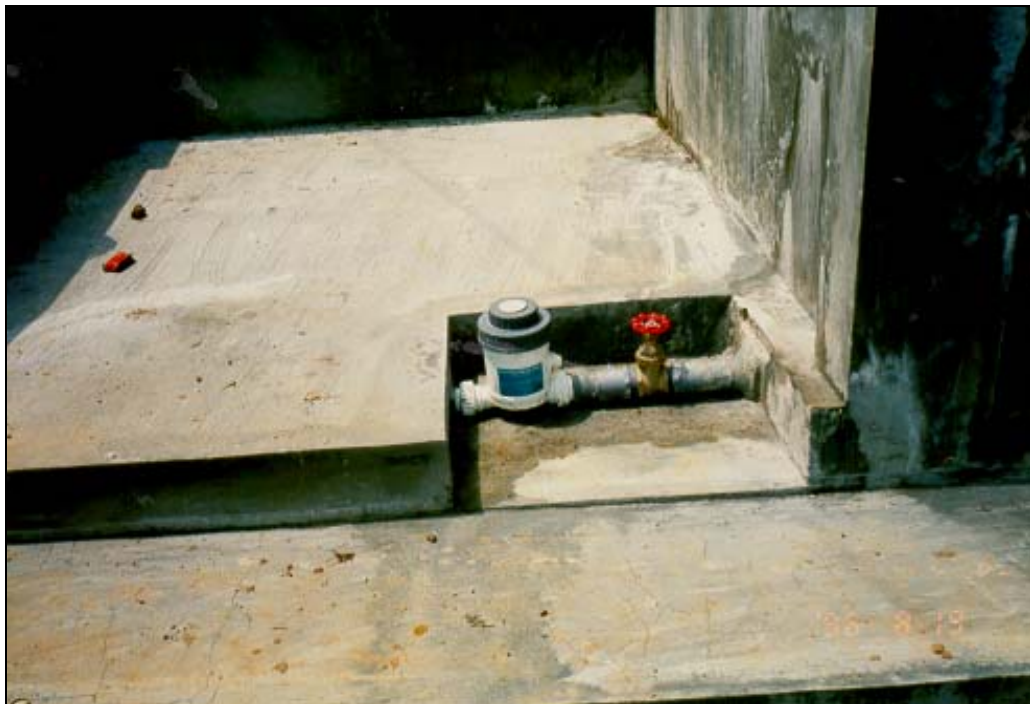
Bentuk alat pembubuh khlorine atau kaporit (bentuk tablet).
