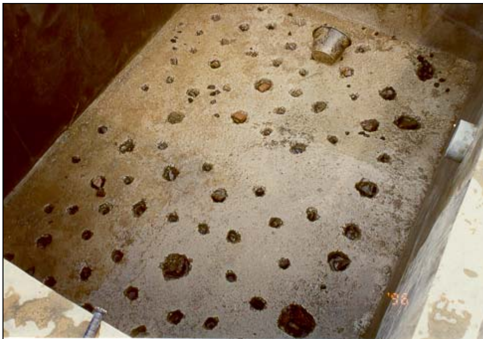
Konstruksi beton penyangga media penyaring
