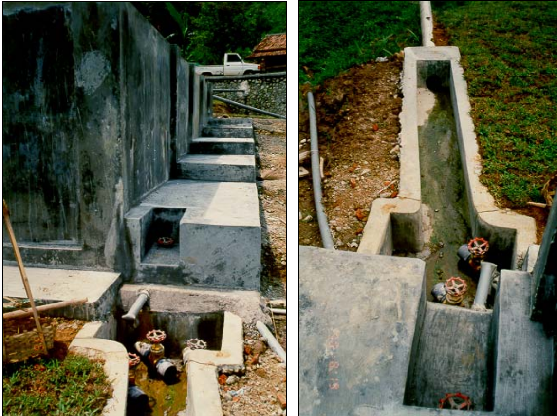
Konstruksi saluran penguras untuk pencucian media filter.
