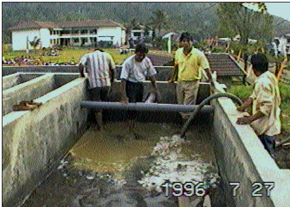
Gambar 6 : Foto pada waktu pencucian pasir dengan pemompaan.
