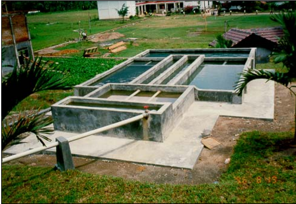
Unit pengolahan air bersih dengan proses saringan pasir lambat "Up Flow" yang sedang beroperasi
