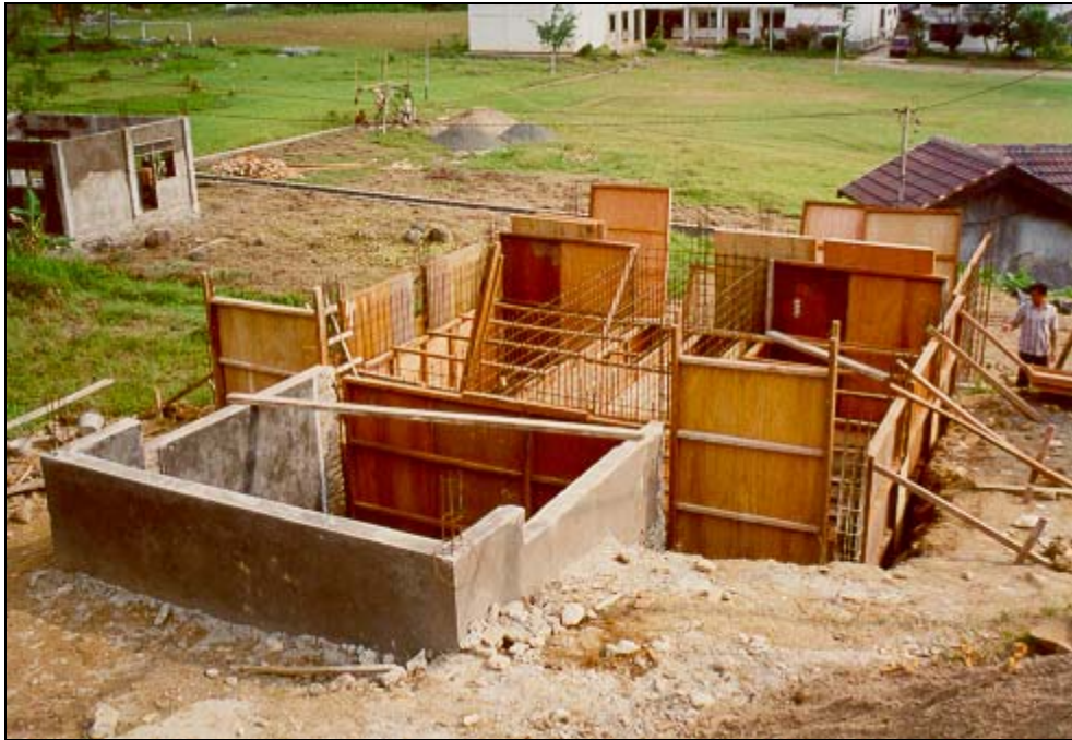
Pembangunan bak penyaringan
