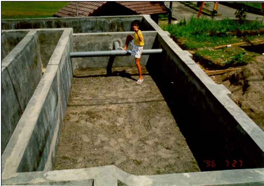
Pengisian media pasir ke dalam bak penyaringan
