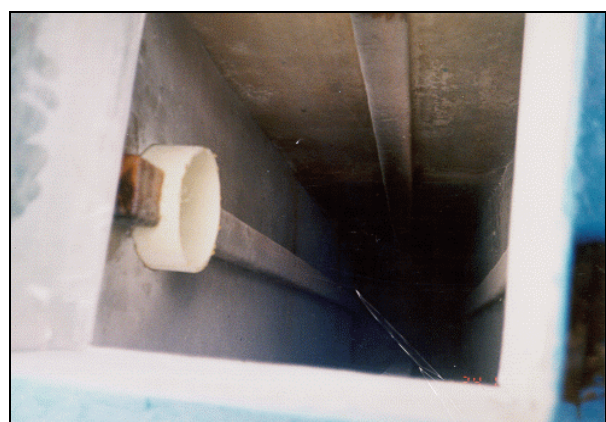
Konstruksi bagian inlet pada bak pengurai anaerob.
