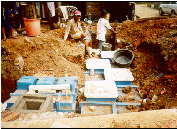
Pemasangan bak pengurai anaerob dan bak reaktor pengolahan lanjut.
