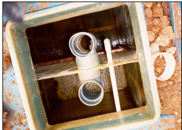
Pemasangan bak pengurai anaerob dan bak reaktor pengolahan lanjut.
