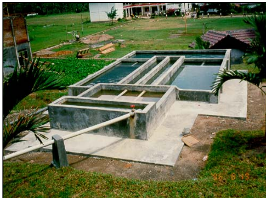
Gambar 5.15 : Unit Pengolahan Air Bersih Saringan Pasir Lambat Dengan Sistem Arah Aliran Dari Bawah Ke Atas ( Up Flow ) kapasitas 100 m 3 /hari. Lokasi : Pesantren La tansa, Lebak, Jawa Barat.
