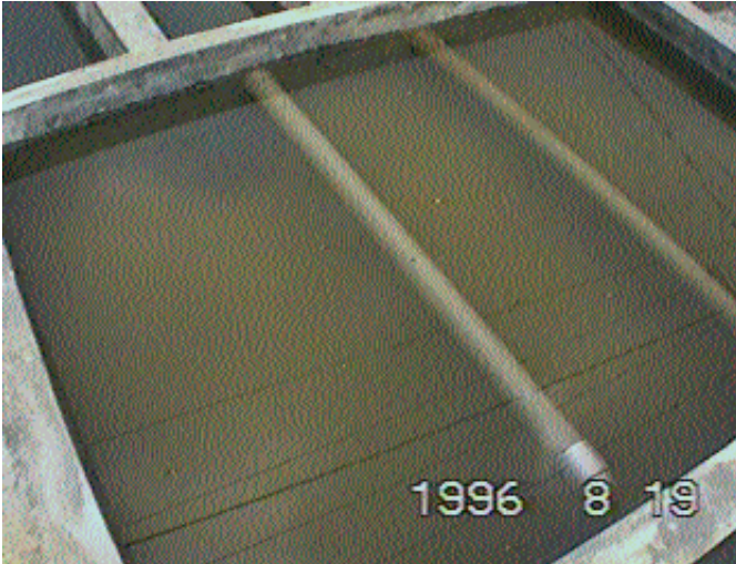
Foto 5.11 : Saringan pasir awal pada unit saringan pasir lambat “Up Flow”.
