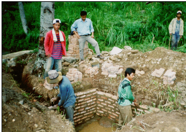
Foto 5.1: Pembangunan bak penangkap air baku.
