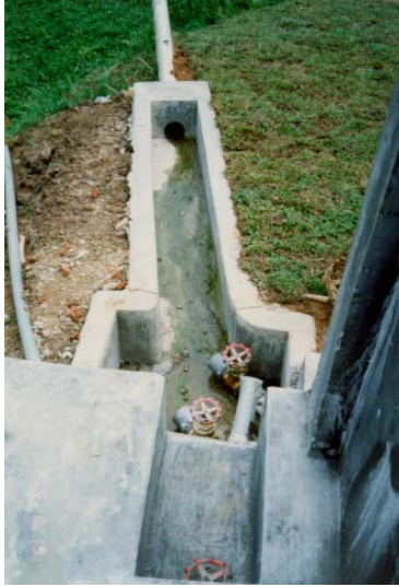
Foto 5.13 : Konstruksi kran pengeluaran (penguras) lumpur pada unit saringan pasir lambat “Up Flow”.
