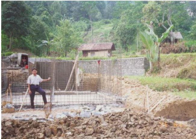
Foto 5.7 : Pengerjaan Lantai Dasar Dan Pemasangan Rangka Besi Pada Unit Saringan Pasir Lambat “Up Flow”.
