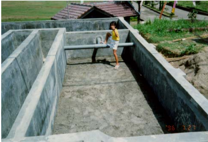
Foto 5.9 : Pengisian media pasir pada unit saringan pasir.
