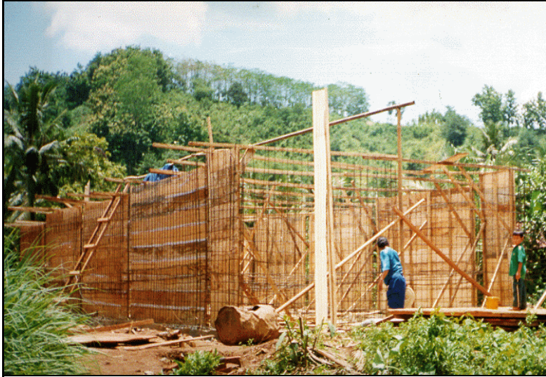
Foto 5.4 : Pembangunan bekisting sebelum dibeton.
