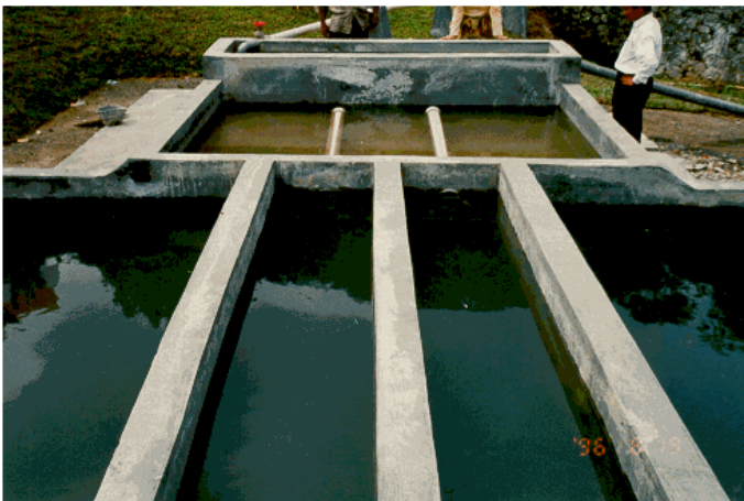
Foto 5. 12 : Saringan pasir kedua pada unit saringan pasir lambat “Up Flow”.
