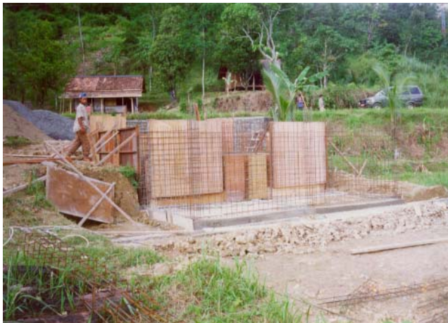
Foto 5.8 :Pengerjaan pengecoran dinding unit saringan pasir lambat “up flow”.
