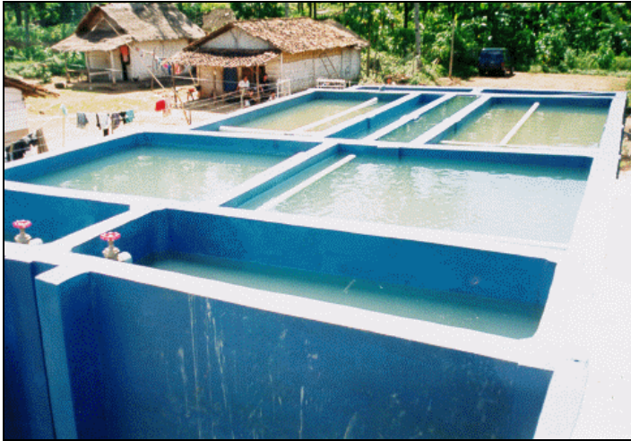
Foto 5.5 : Unit Sarpalam Up Flow kapasitas 100 m 3 /hari setelah diisi air.
