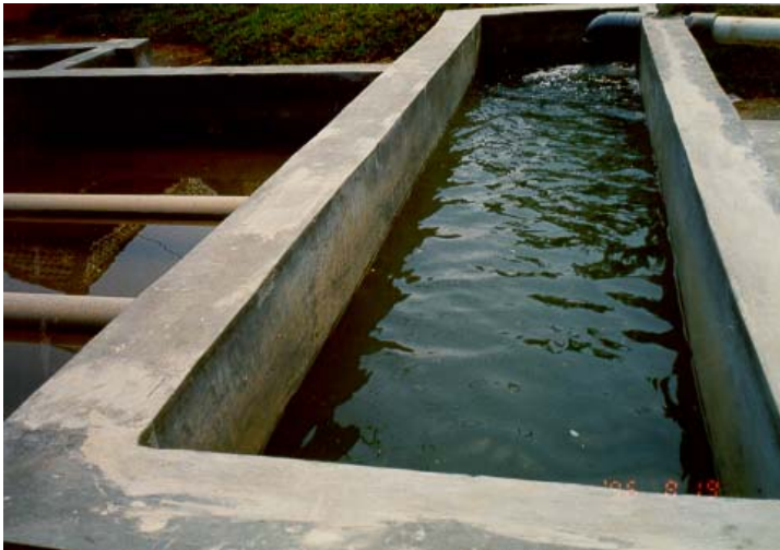
Foto 5 10 : Bak penenang pertama pada unit saringan pasir lambat “Up Flow”
